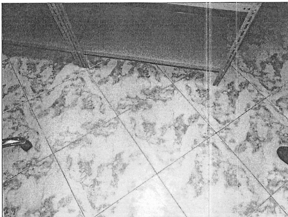
Imagem 12: Arquivo Geral: piso revestido com cerâmica.
